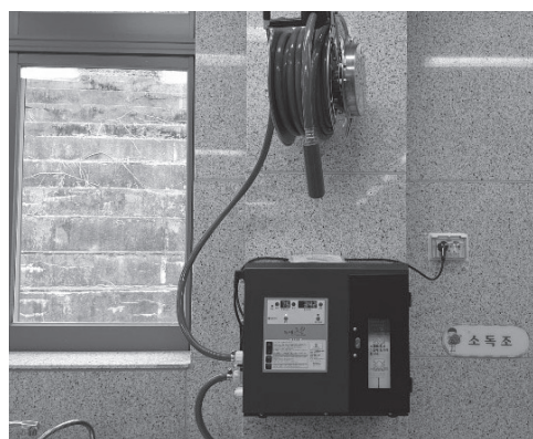
그림 소형 경량화된 전기분해식 대용량 살균수제조장치 SSG-1600
